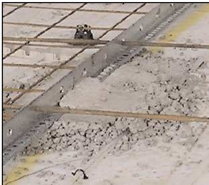
Szyny Permasteel 70 mm na materiale izolacyjnym z systemem rur ogrzewających umieszczonych pod szyną
